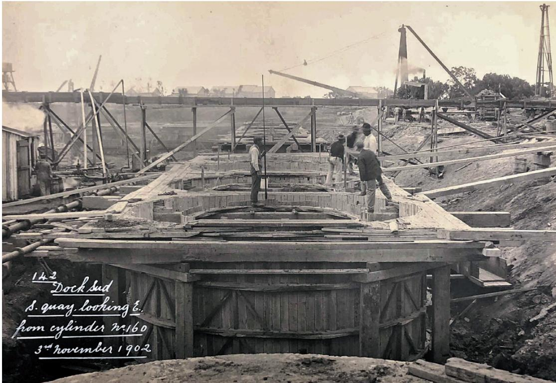
Colocación de pilotes de hormigón apoyados sobre la tosca. Año 1902.
